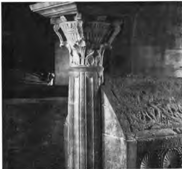
Fig. 36. — Chapiteau carolingien de la crypte de Jouarre. Développement donné au tailloir pour recevoir les voûtes.
